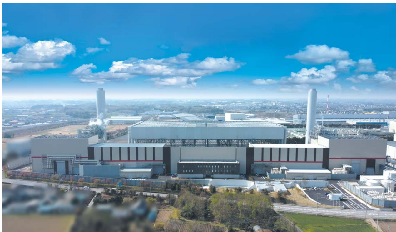
<神戸製鋼所真岡発電所>
